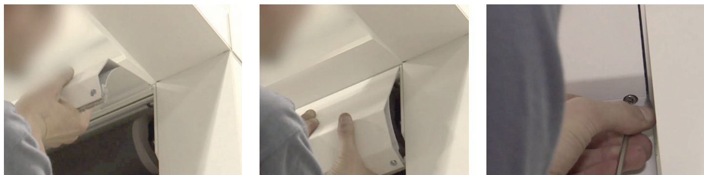
Insérer le capot dans la glissière, abaisser le capot et visser de chaque côté à l'aide des vis M5
