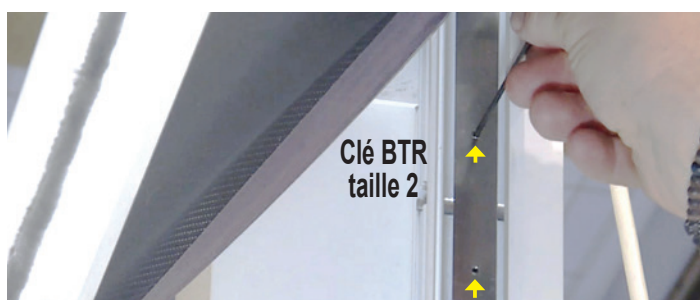
Bloquer à la bonne position l'ensemble coffre et coulisses à l'aide des 2 vis de pression M4 déjà en place sur les joues
