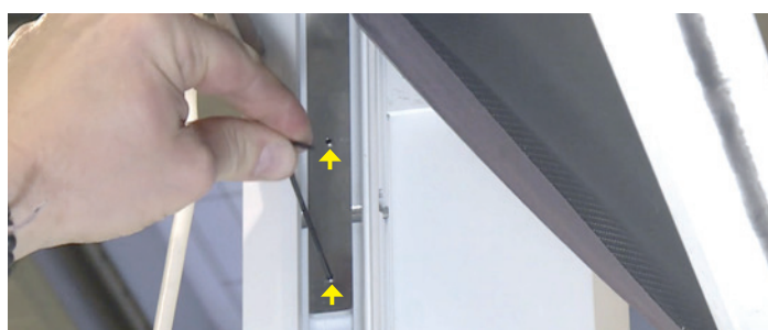
Bloquer à la bonne position l'ensemble coffre et coulisses à l'aide des 2 vis de pression M4 déjà en place sur les joues
