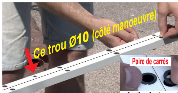
Paire de carrés 2 paliers fendus par trou 1 dessus et 1 dessous
