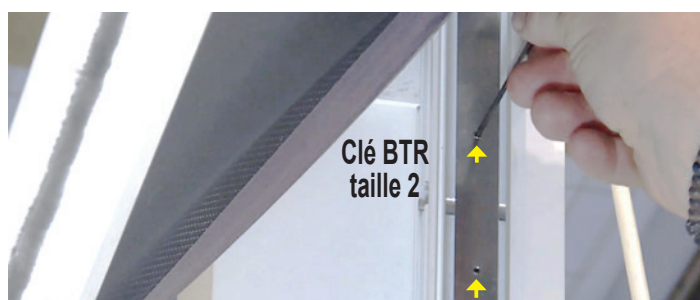
Insertion des coulisses sur le coffre
