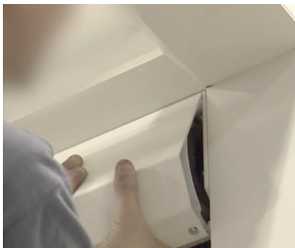
Insérer le capot dans la glissière, abaisser le capot et visser de chaque côté à l'aide des vis M5
