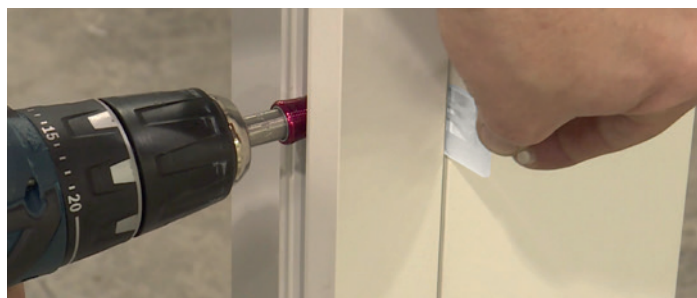
Caler le dos des coulisses avant vissage si besoin, les coulisses doivent rester rectilignes ou problème à l'enroulement
