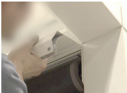
Insérer le capot dans la glissière, abaisser le capot et visser de chaque côté à l'aide des vis M5
