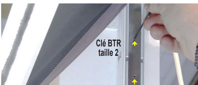
Insertion des coulisses sur le coffre
